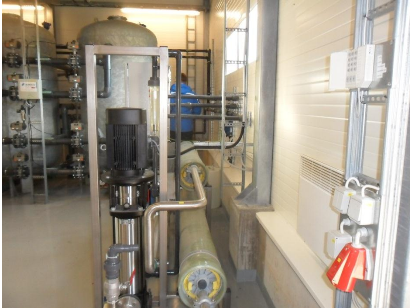
Joonis 5-6 Kaarlimäe VTJ PO-seade
