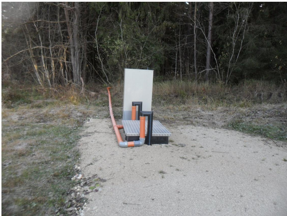
Joonis 5-10 Riiska II reoveepumpla õhustustoru otsik on viidud eemale kraavi elanikke häiriva lõhna vältimiseks
