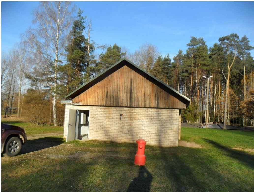
Joonis 5-1 Riiska puurkaevpumpla välisvaade (nähtav hüdrofoor on paigaldatud magistraalvõrgule, mitte pumplast vahetult väljuvale torustikule)
