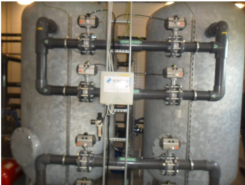
Joonis 5-5 Paarisfilter rauaeralduseks
