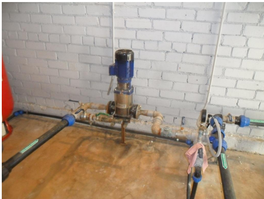
Joonis 5-3 Riiska pumpla II-astme pump
