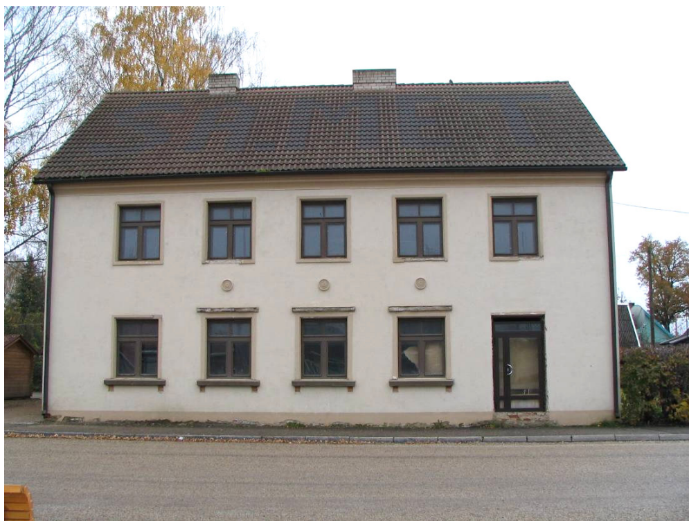
Kevade tn äärne hoone fassaad
